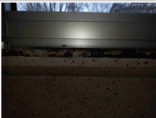
Prélèvement - P028 : R+1 / CIRCULATION 144 - Joint d'étanchéité entre menuiserie et structure- (Absence d'amiante)
