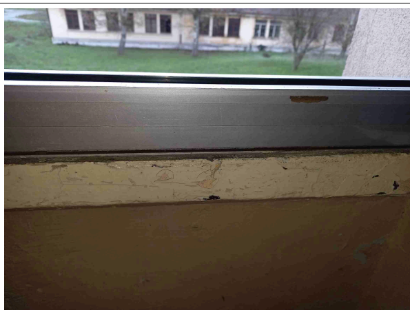
Prélèvement - P003 : R+1 / PIECE 108 - Joint d'étanchéité entre menuiserie et structure- (Absence d'amiante)
